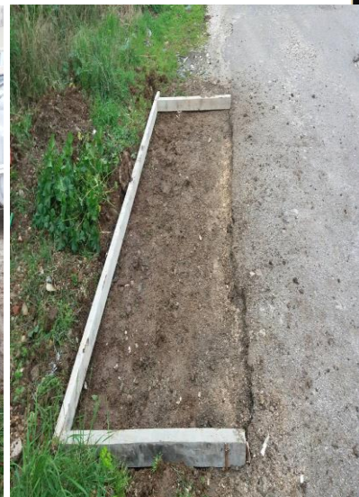
PRIPREMA ZA ZIDANJE KONTEJNERSKOG MJESTA 2019
